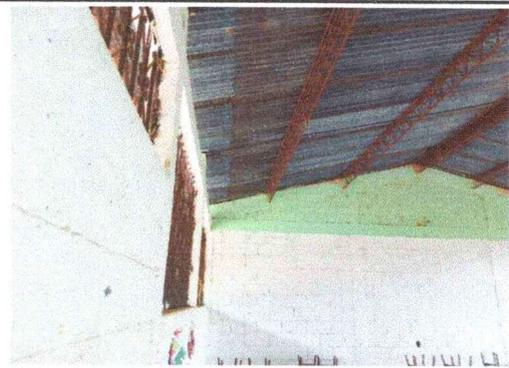
Se observa el mal estado de la estructura metálica del techo, que están oxidadas por la antigüedad de las mismas.
